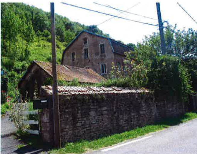
Mur de clôture
