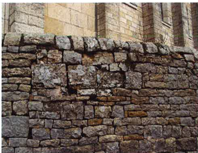
Mur de soutènement en pierres sèches
