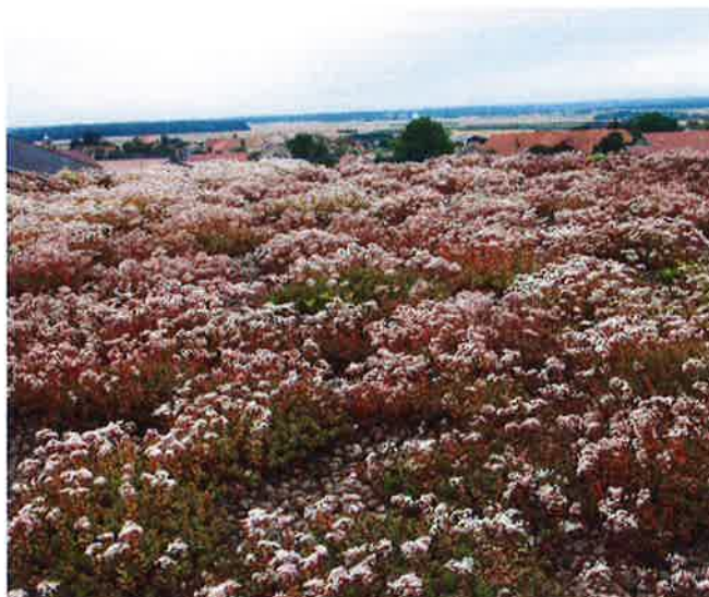
Exemple de toiture végétalisée - sédum majoritaires
